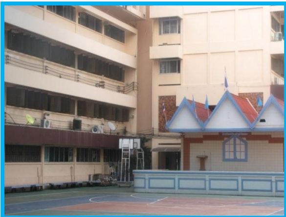
อาคารวารี (ชาย) และอาคารนที (ขวา)
